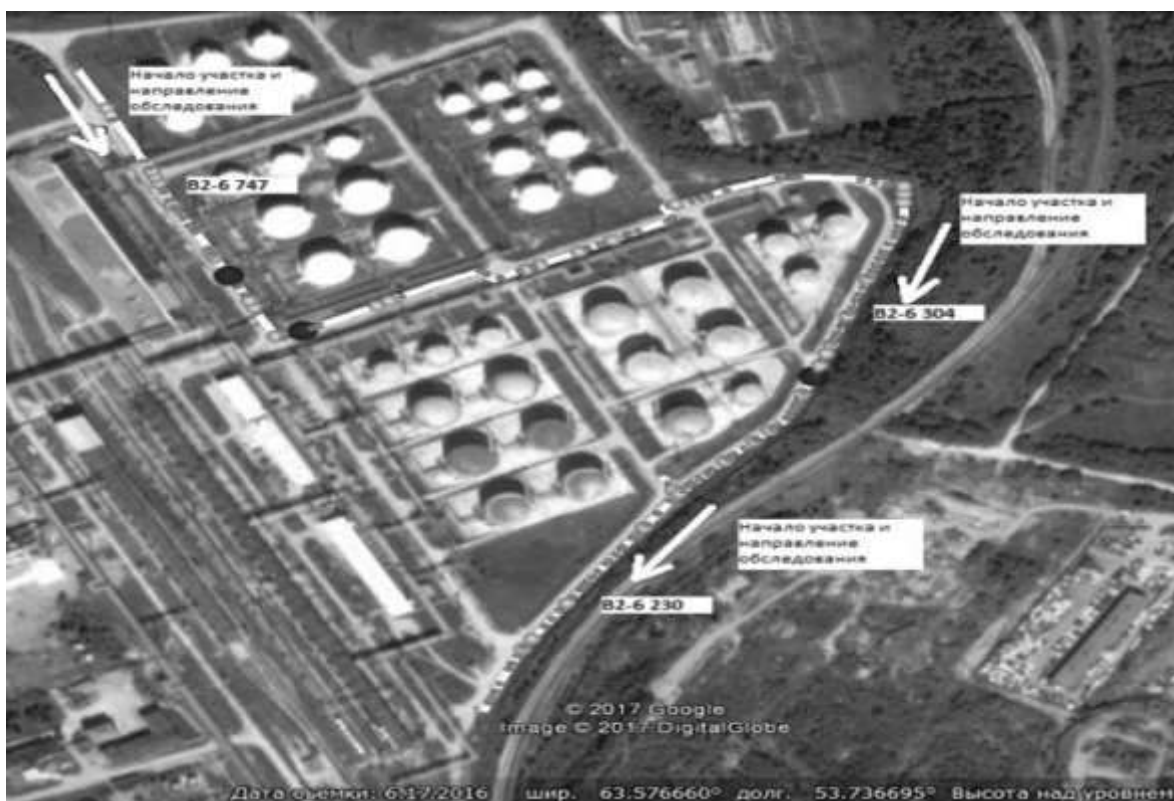
Рисунок 2. Результаты сканирования противопожарного водопровода В2-6 ООО «ЛУКОЙЛ-УНП»
