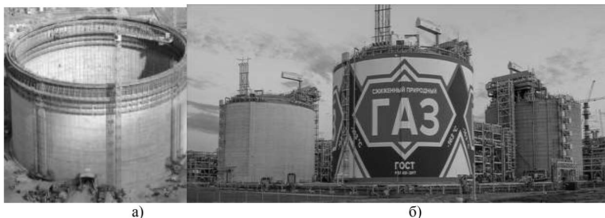
Рисунок 8. Резервуары на объекте Ямал СПГ: а – резервуар СПГ во время строительства, б – резервуар СПГ во время эксплуатации
