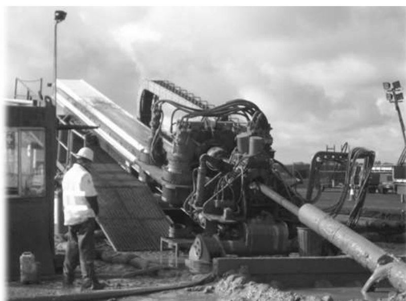
Рисунок 3. Буровая установка с наклонным ставом речного типа
