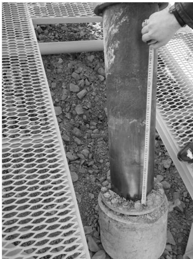
Рисунок 5. Удлинение при нагреве промежуточной колонны
