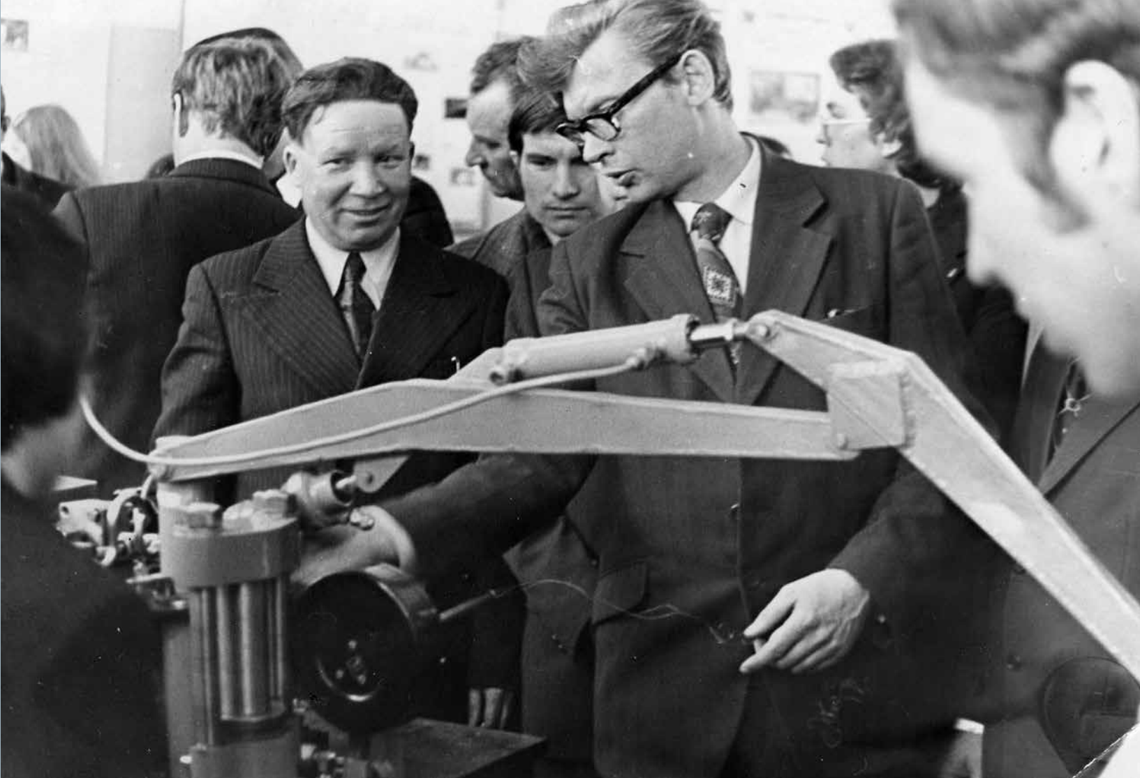
Доцент ЛТФ Г.П. Дроздовский демонстрирует работу макета гидроманипулятора. 1978 г.
