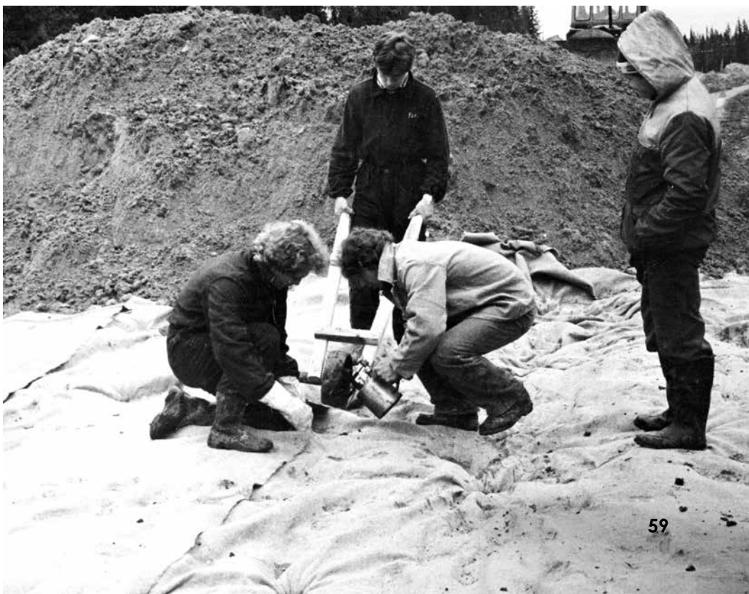
Студенты лесотехнического факультета на производственной практике в ВПО «Комилеспром» укладывают земляное полотно дартит на болотистом участке дороги Нижний Одес — Вуктыл. 1982 г.
