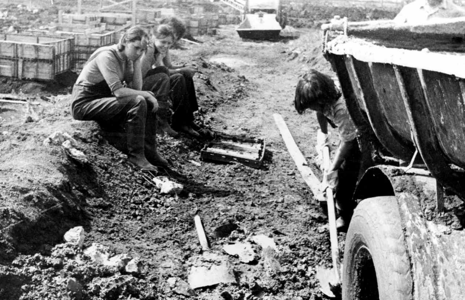
На строительстве дороги. Башкирия, п. Шакша, 1978 г.
