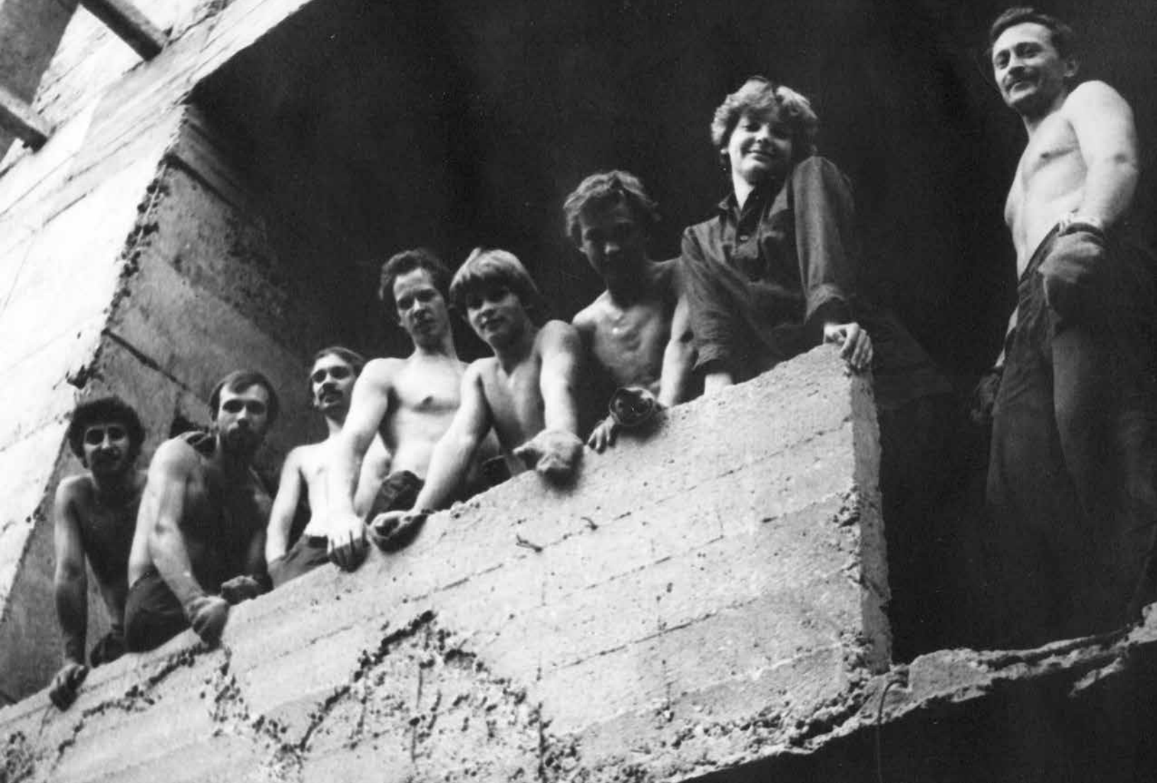
На стройплощадке. ССО «Северянин», Болгария, г. Ловеч, 1982 г.
