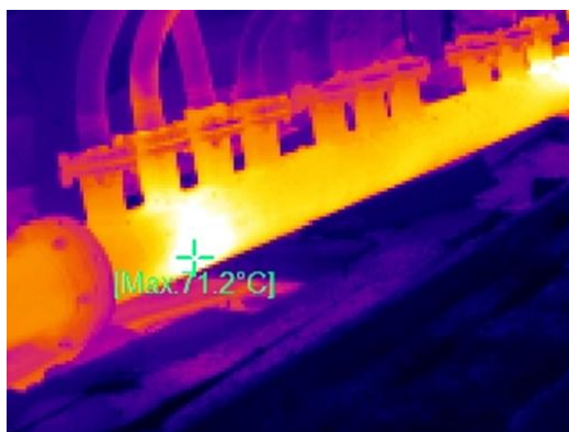
Рисунок 4 – Тепловизионная съемка ЗСН в УБ 4Т-4 до теплоизоляции
