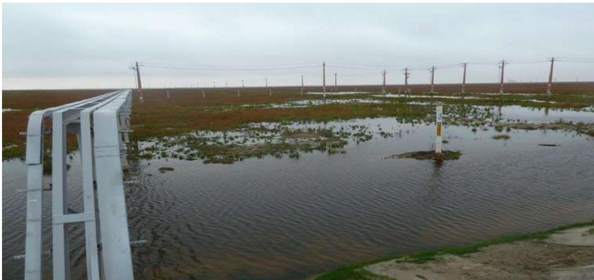
Рисунок 2 –Результат развития термокарста на стадии эксплуатации
