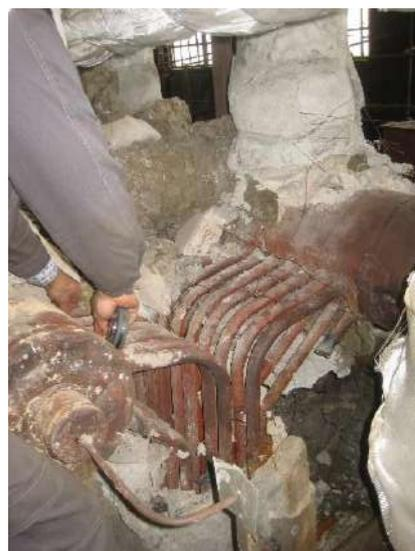
в – трубы коллекторов конвективной поверхности пароперегревателя без ограничения по эксплуатации
