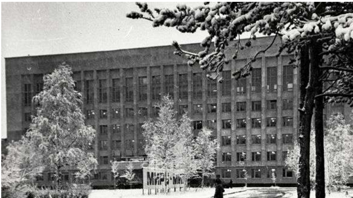
Рисунок 1 - Здание института «ПечорНИПИнефть», г. Ухта, ул. Октябрьская 11.
