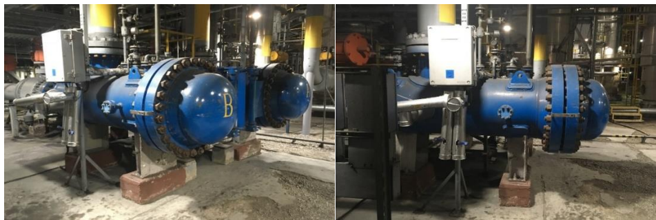
Рисунок 2 – Фильтр осушенного газа
