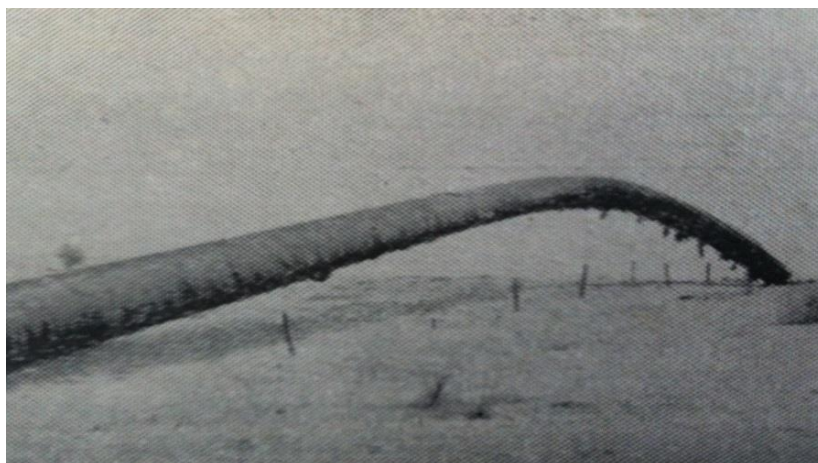
Рисунок 3 - Арочный выброс трубопровода
