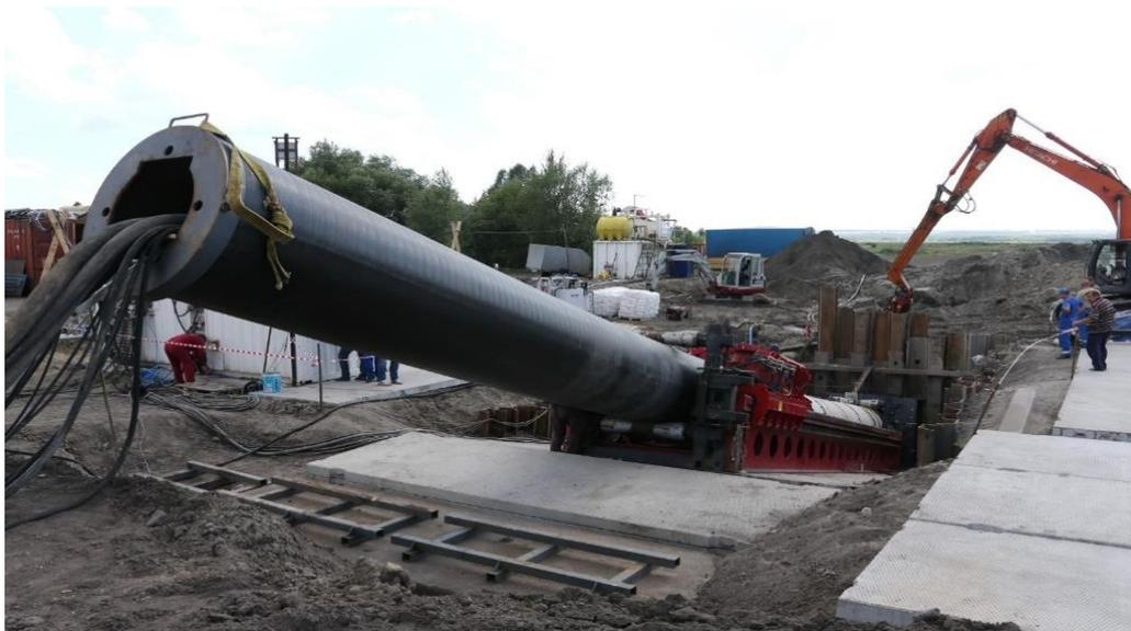
Рисунок 5 - Расширенные возможности применения «метода кривых» при использовании обетонированных труб «Зуб-Компазит»
