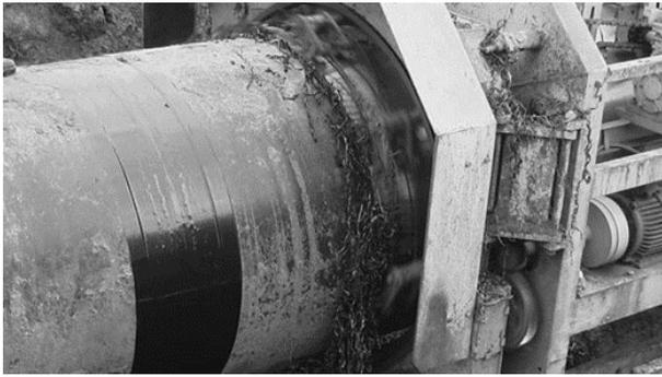
Рисунок 3 - Наглядное изображение очистки трубы резцовыми инструментами
