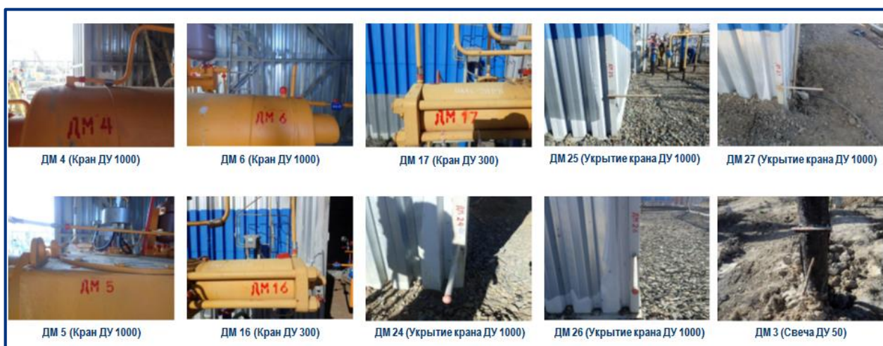
Рис. 2 - Тригонометрическое нивелирование деформационных марок
